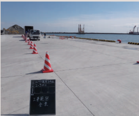
※工事範囲全景
