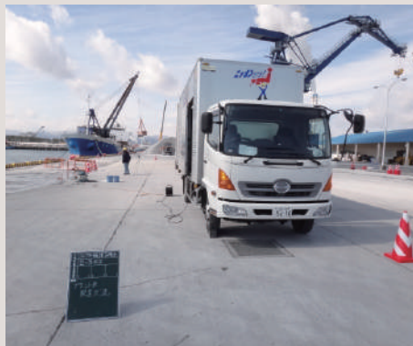
※施工プラント車配置
