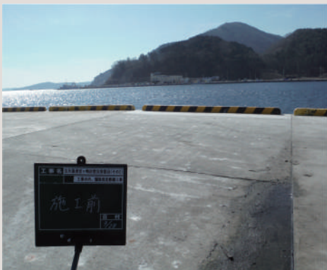
女川漁港・魚市場の水揚げ岸壁
