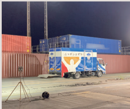
※施工プラント車配置
