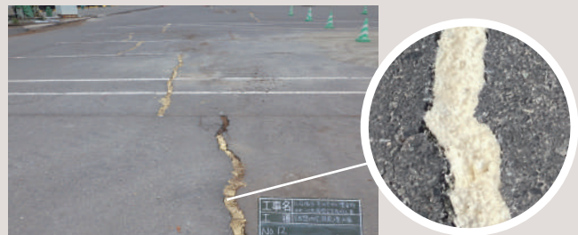
隙間なくウレタン樹脂を充填
