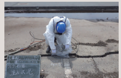
ウレタン樹脂注入の様子
