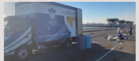
資機材一式を搭載した施工プラント車
