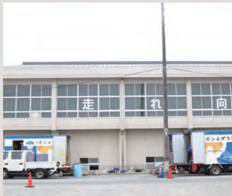
施工プラント車配置
