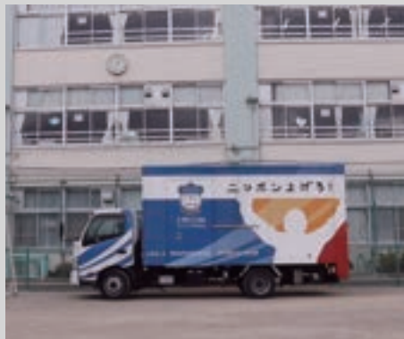
施工プラント車配置
