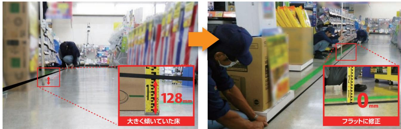
沈下によって、傾きが発生していた床
