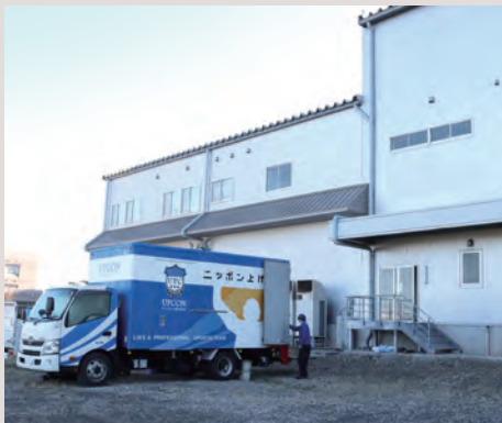
施工プラント車配置
